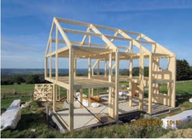
Les constructions en poteaux-poutres bois et remplies par des blocs de chanvre sont idéales pour atteindre des murs zéro carbone. Ce système est le plus Eco-responsable.
