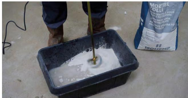
2 Préparez le Mortier Colle avec 7 à 8 l d'eau pour un sac de 25 kg, en ayant pris soin de verser le mortier colle dans l'eau et non l'inverse. Le mélange reste utilisable pendant une heure.
