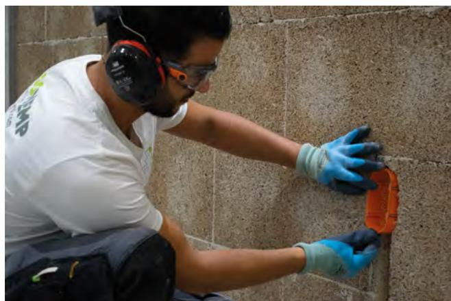
4 Récupérez les déchets de vos découpes de blocs de chanvre et broyez-les. Mélangez-les ensuite avec le liant Prokalk à raison de 50% l'un et 50% l'autre. Hydratez le mélange ainsi obtenu avec de l'eau de manière à obtenir un mélange homogène et légèrement humide. Remplissez les cavités avec le mélange.
