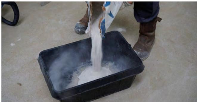
1 Le collage se fait exclusivement à l'aide du mortier colle IsoHemp, à défaut IsoHemp ne peut être tenu responsable de tout dégradation de maçonnerie liée au collage. Bien respectez les instructions indiquées sur les sacs de mortier colle.
