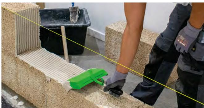
5 Appliquez la colle à l'aide d'une truelle crantée IsoHemp sur toute la surface horizontale du bloc déjà posé pour assurer l'étanchéité du joint.
